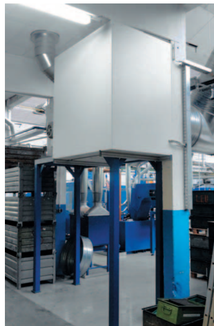
Halboffene Laermschutz-Teilverkleidung fuer Waerme-tauscher mit Geblaese Laermpiegelreduzierung 15 dB(A)
